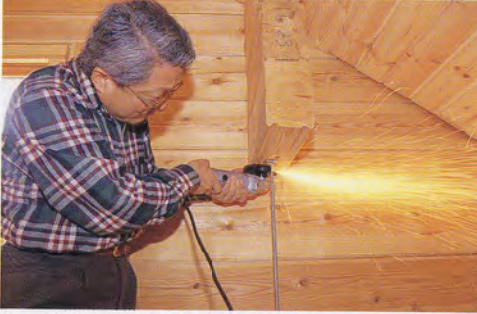
上の写真（ロフト部分）を撮影しようとする「ちょっと待って」とまたまた登場した田中さん、今度はディスクサンダーで余分なボルトを切断し始めた。1年10カ月にもわたるログハウス造りは、田中さんを素人からセルフビルダーへ変えたようだ
