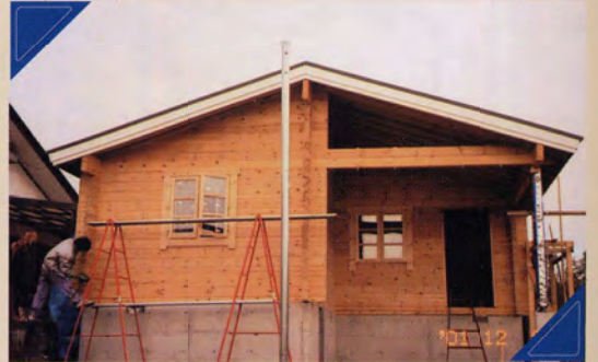
作業中の急な雨にはビニールシートで対応。屋根の棟部分の両脇にポールを立て、建物全体を簡単に覆えるようにした
