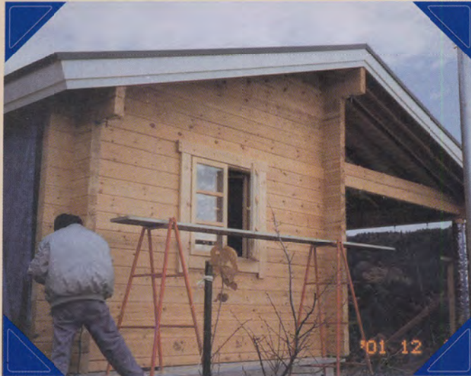
肩の位置より高い部分の、ログ組みや大工仕事は一苦勞。しっかりと安定した足場を組んで安全に作業を進めた
