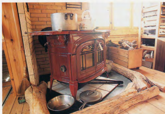
デザインと色が気に入っているアメリカ製アンコール。薪を燃やしたまま寝ても心配なく、朝まで暖かい。床に敷いているのは鉄板、丸太は猫の爪とぎにもなっている。夏はとりはずすだけ。
