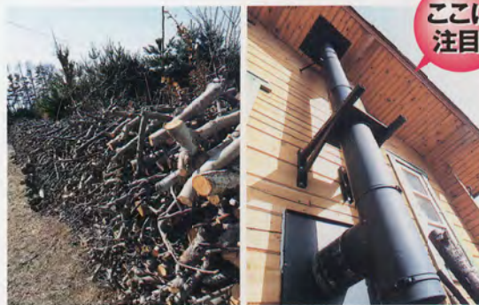
施工のしやすさから一回曲げているが、煙突は屋根へまっすぐ通した方がよかった。(右) 薪ストーブを使うなら、半年から1年乾燥させることを考えて、常に3年先ぐらいいまで薪を確保した方がいい。(左)
