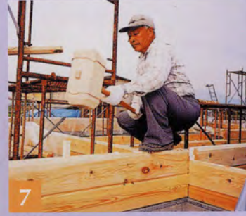
6 6/11 記念すべき1本目のログの施工。これは基礎の上の1段目のハーフログ。
