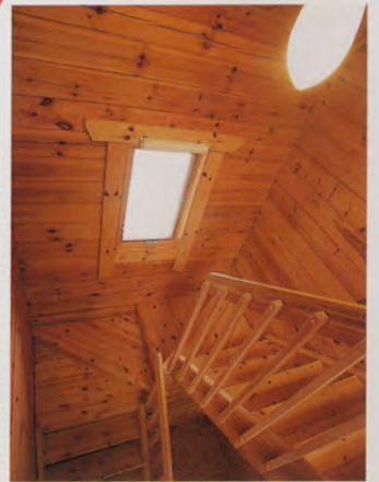
吹き抜けにログ材を根太として取り付けてある。将来、畳や床に変更できるようにしてある
