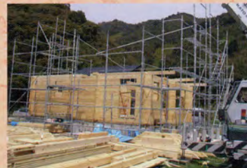
2003年4月～ ログ組み ログ積み、断熱材貼り、カケヤでのダボ打ち等体力勝負の作業。高所での作業は注意した
