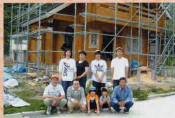
2003年5月 外壁塗装 友人と外壁の塗装作業。好天で、2回塗りが2日間できた。予定より早く終わった
