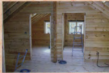
2003年5月～ 内装作業 屋根工事完了後、床板、天井板等の各種板張り、内部額縁等々、様々な作業を行った
