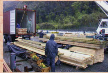
2003年4月 部材搬入 途中で部材の積み替えをするため業者に依頼。1日の予定が雨などの影響で2日かかった
