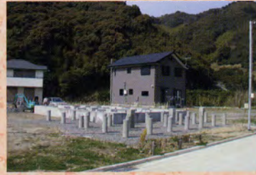
2003年3月 基礎工事 基礎は業者に依頼。床下工事及び今後のメンテナンスを考慮して、高さは60cmにした
