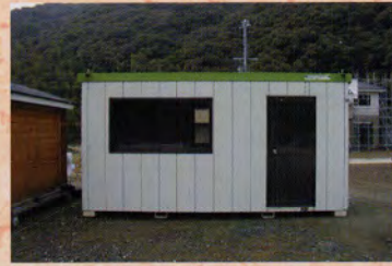
2003年4月～ 仮住まい 敷地内にコンテナハウスを建てて半年間仮住まいした。キッチンや風呂もなく不便だった
